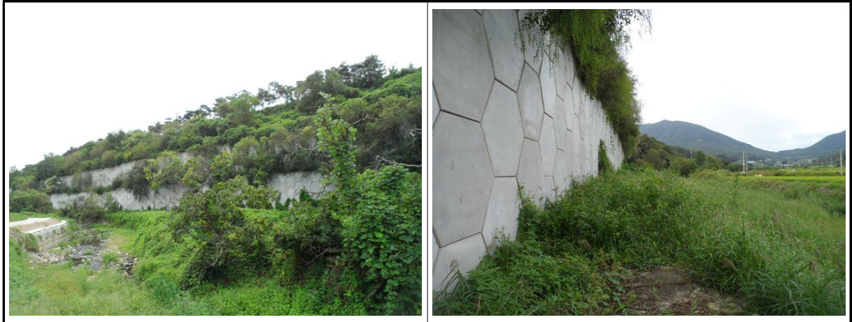
【사진 2.3.1】 지반, 기초부 전경
