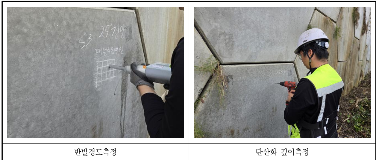
【사진 2.4.1】 재료시험 조사 전경
