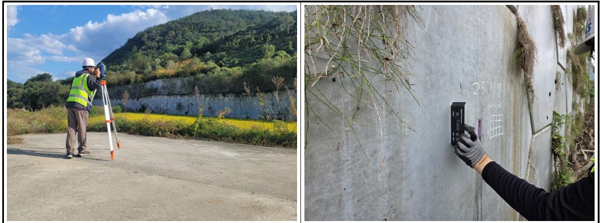
【사진 2.4.2】 측량작업 전경
